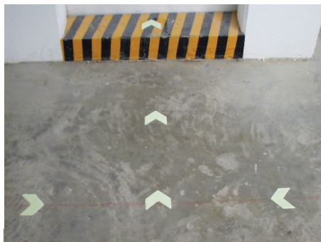
Bodenmarkierungspfeile aus 3-K Schnellgießharz. Hohe Belastbarkeit, geeignet für z.B. Staplerverkehr, Tiefgaragen
